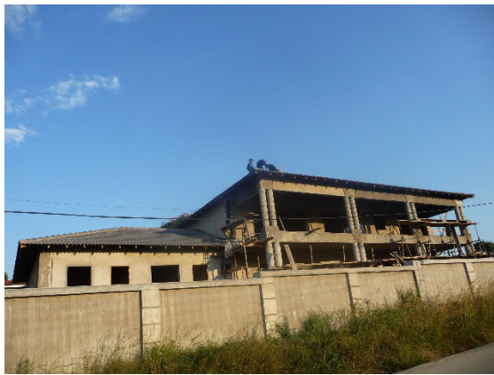
Rohbau fast fertig
