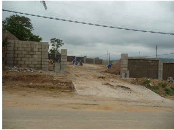
Baubeginn, die Außenmauer steht
