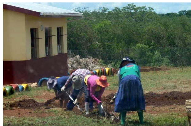
Graben für die Wasserleitung
