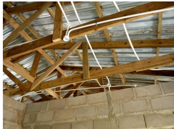
und auch das Dach hat eine solide Konstruktion
