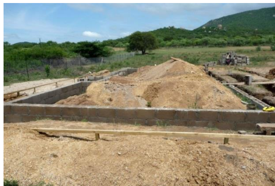
die ersten Reihen Steine sind gelegt
