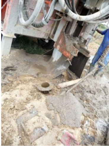
das Bohrloch wird angelegt
