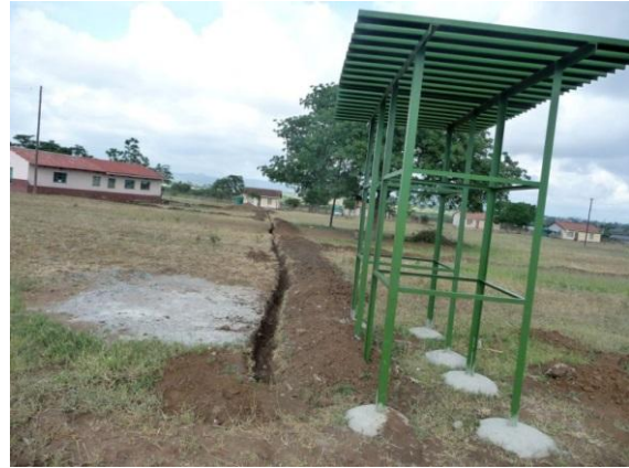
ein Graben für die Wasserleitung wird gezogen
