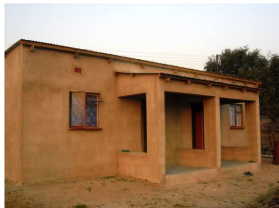
die Lehrerunterkunft ist fertiggestellt
